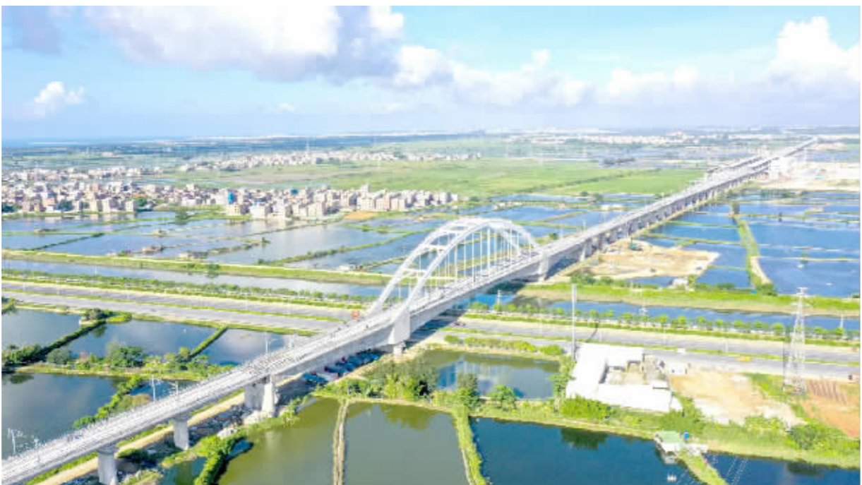
惠来县全面加强基础设施建设,夯实高质量发展的基石。图为汕汕高铁雷岭河特大桥。 林碧鸿 摄
