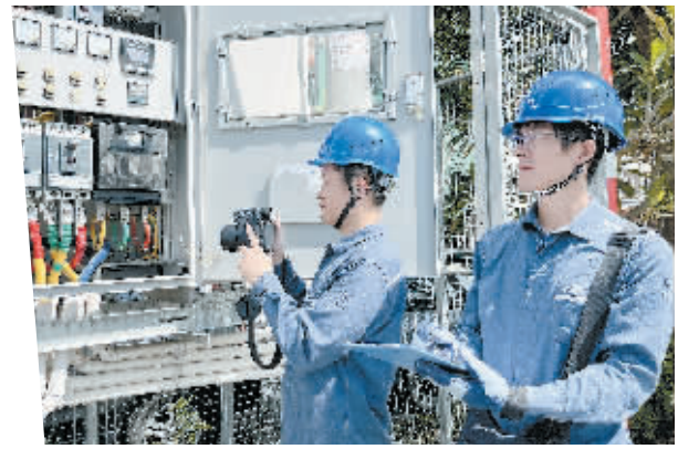
揭西供电局工作人员开展特巡,保障“双节”期间安全稳定用电。
