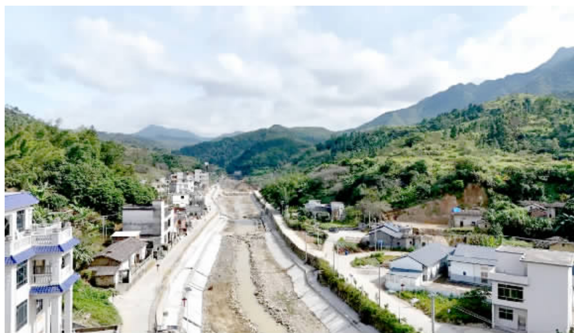
良田河(龙岭村、河水村段)山洪沟治理工程稳步推进。
