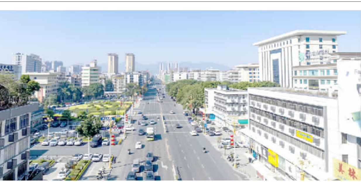
经过改造后的流沙大道普宁市机关大院前路段两侧老旧小区外立面焕然一新。
