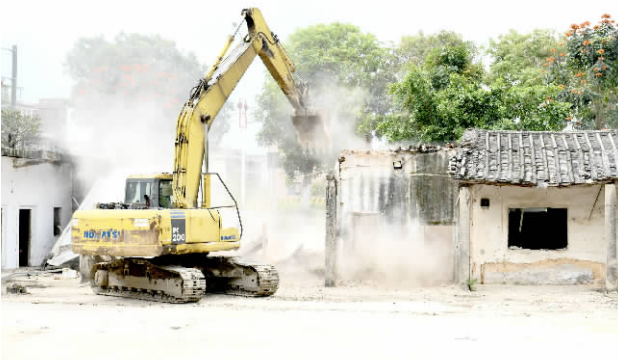
普宁市全域掀起“三清三拆三整治”热潮，对危破房、乱搭乱建构筑物进行拆除。
