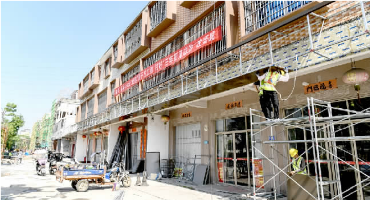
普宁市交通主干道联镇带村成片风貌带及主干道整治提升工程正如火如荼推进中。
