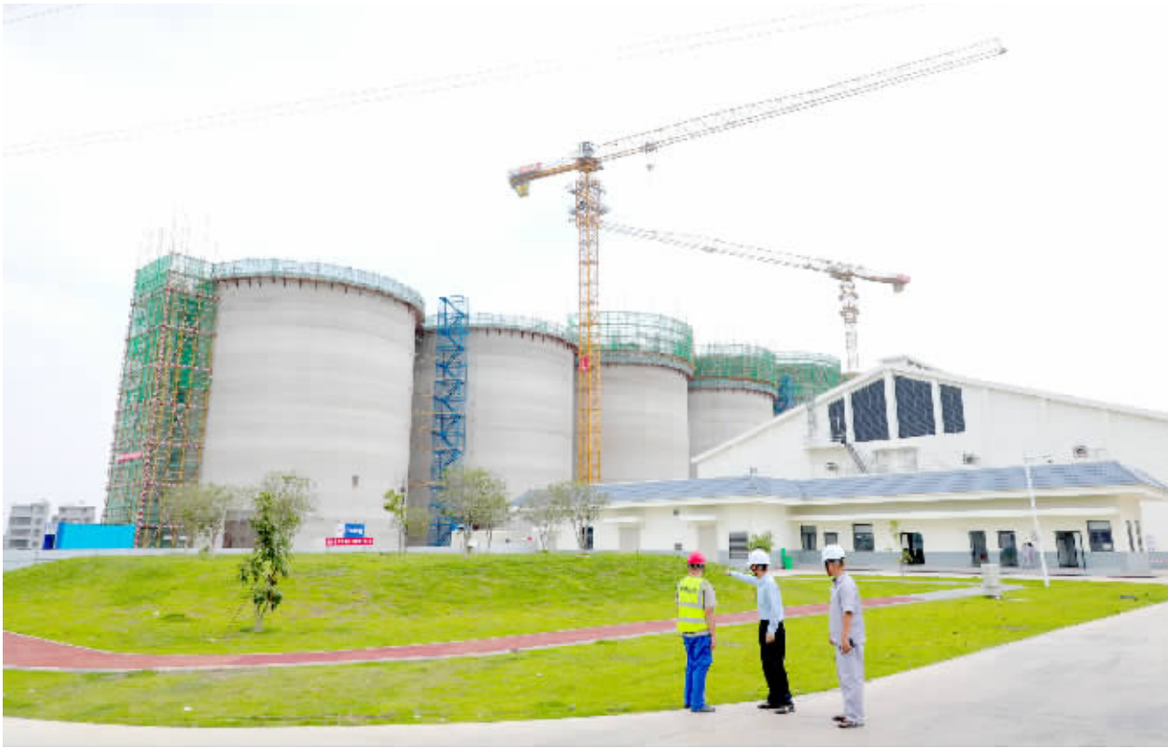
榕城区多措并举强化建筑工地文明施工、扬尘治理工作，推动文明施工赋能城市形象提升。
