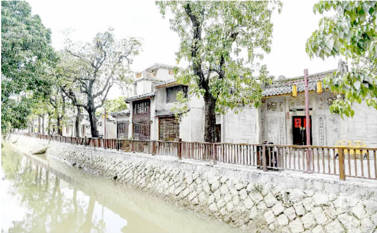
人大代表积极建言助推城乡焕新。图为整治后的绍兴路,废弃电线杆已清除,路面环境提升,安全感满满。
