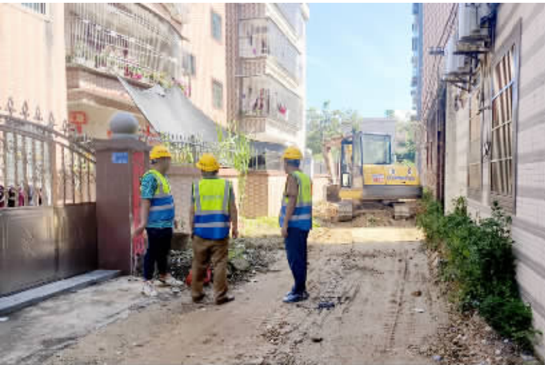
云落镇加速推进村道巷道硬底化工程,改善村民出行环境。
