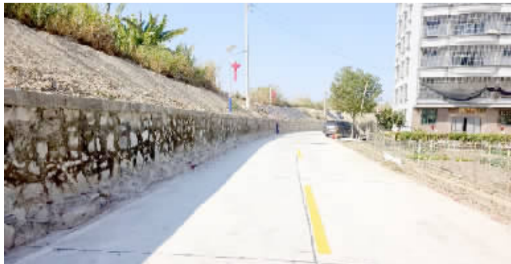
南径镇持续推动“四好农村路”建设，切实保障群众出行安全。 通讯员 摄
